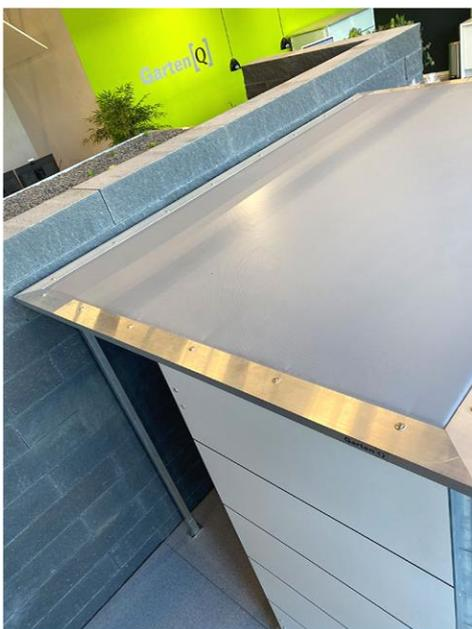
Im Standardfall hat der Garten[Q] Various eine Flachdachkonstruktion. Diese ist mit einer hochwertigen Spezial-Dachfolie bespannt. Sie ist wasserdicht, wasserabweisend und vor allem UV-beständig.
