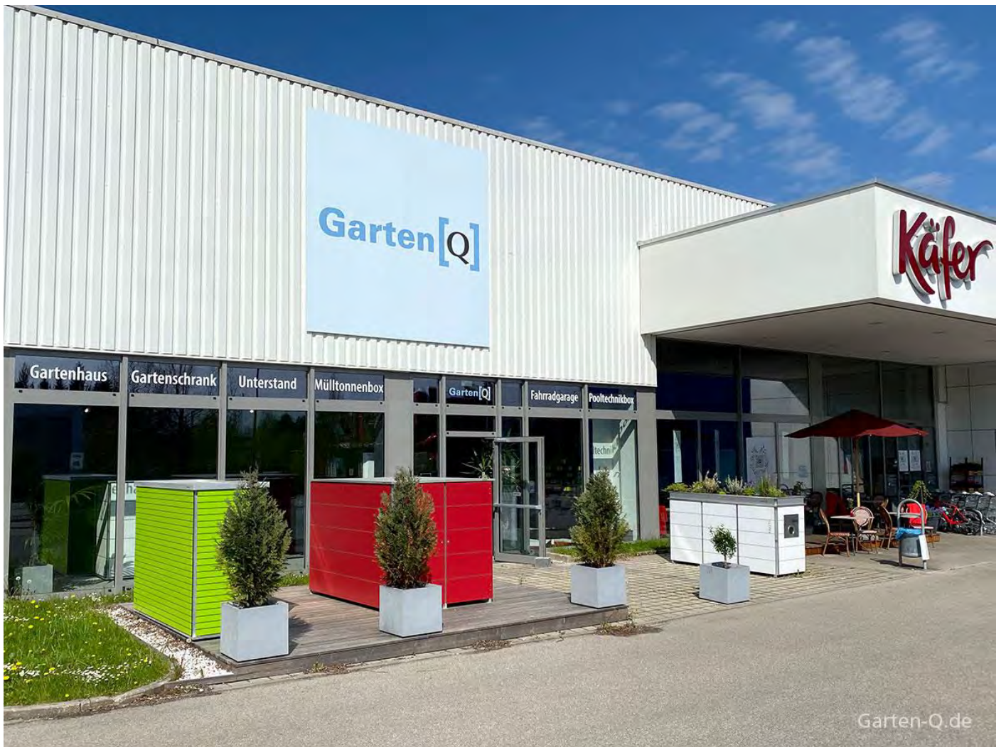
Garten[Q] :: Center in München Brunnthal direkt im Autobahndreieck München-Süd
